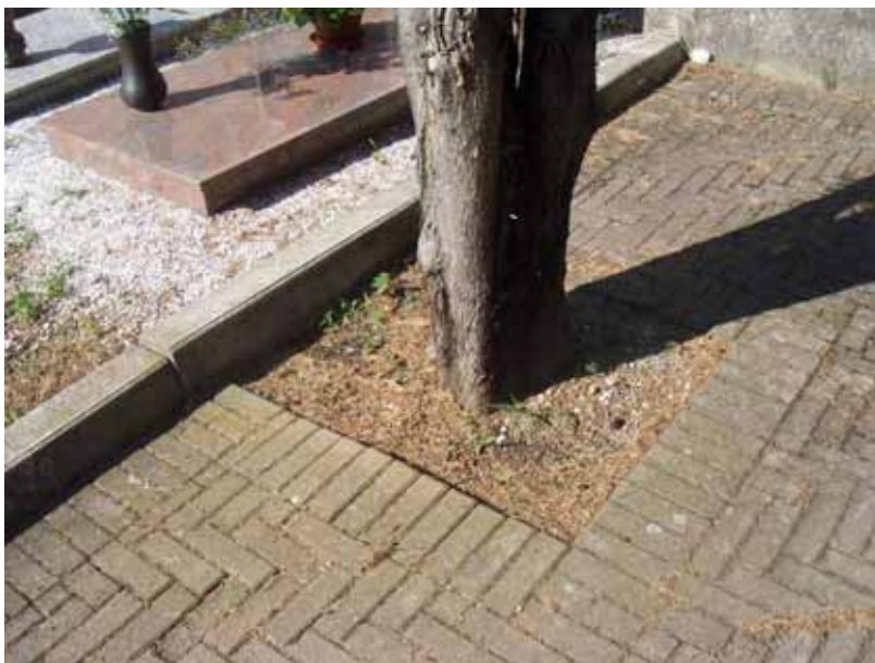
Dettaglio della pavimentazione esistente
